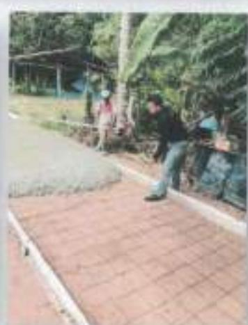
2. โครงการก่อสร้างระบายน้ำ คสอ.ปิดด้วยฝาตชะการเหล็กบ้านหนองฟือ หมู่ที่ 8 ,บ้านหนองฟือบุรา
